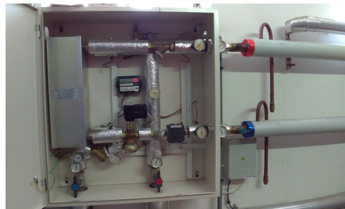
Fig. 4 – centralina allaccio rete teleriscaldamento
