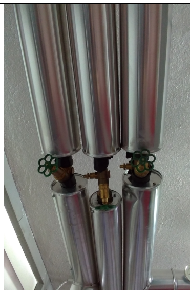
Fig. 6 – condotte a vista circuito acqua calda sanitaria nel locale stazione termica
