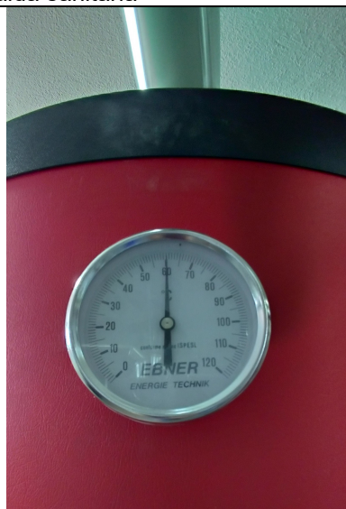
Fig. 5 – termometro fisso del boiler
