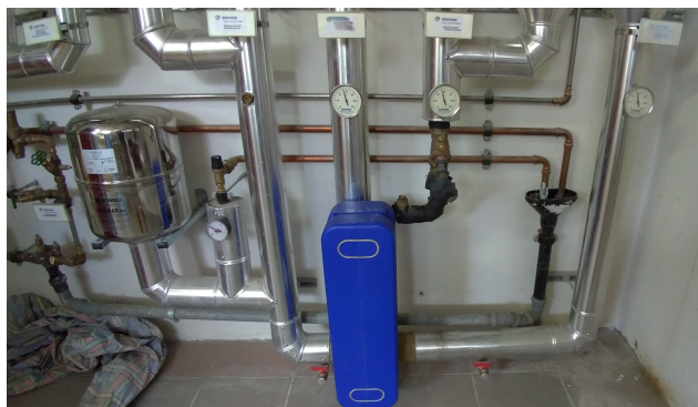
Fig. 3 – scambiatore esterno al boiler produzione acqua calda sanitaria
